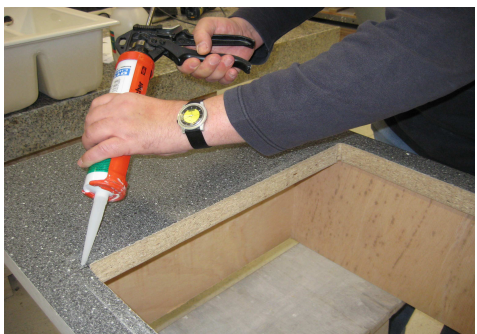
Silikon (ca. 5 mm dick) am äußeren Rand der Auflagefläche auftragen!
