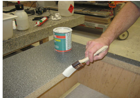
Abdichten der Ausschnitttränder mit einem Primer.
