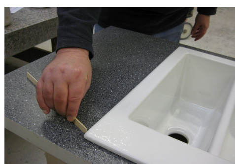
Überquellendes Silikon entfernen. Ablaufgarnitur fertig montieren.
